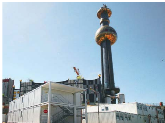
Bureau de chantier
