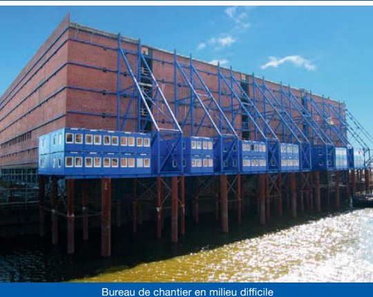
Bureau de chantier en milieu difficile
