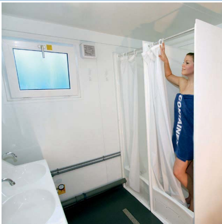
Bungalow sanitaire avec lavabos et cabines douches
