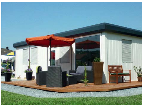
Salle de repos pour chauffeurs de taxi
