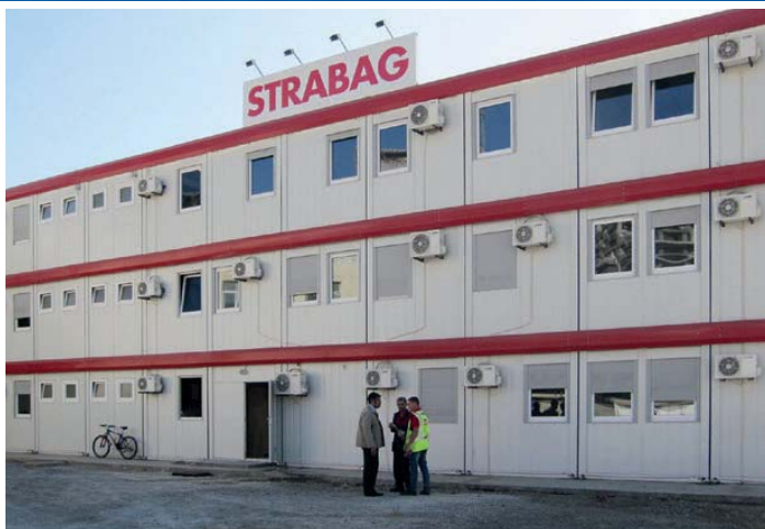
Bureau de chantier
